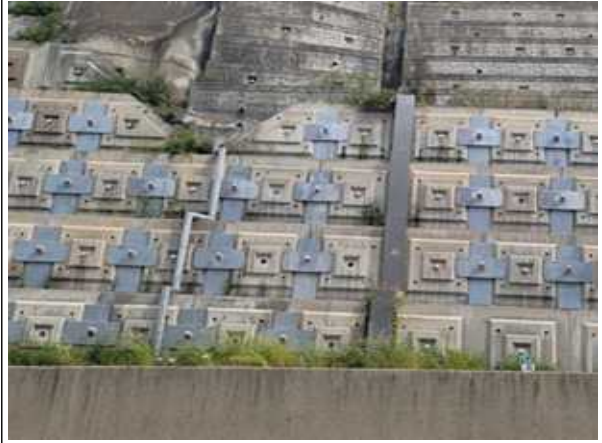
배수관, 배수로 전경
