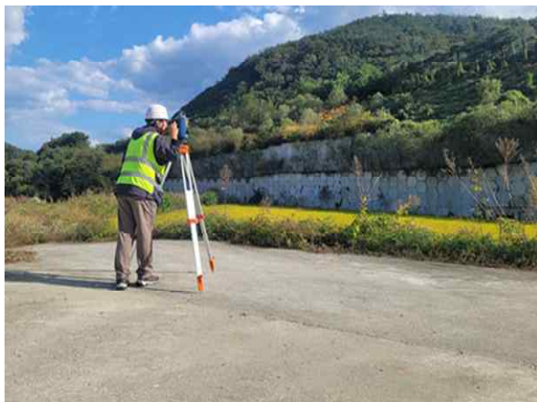
광파기를 이용한 측량 작업
