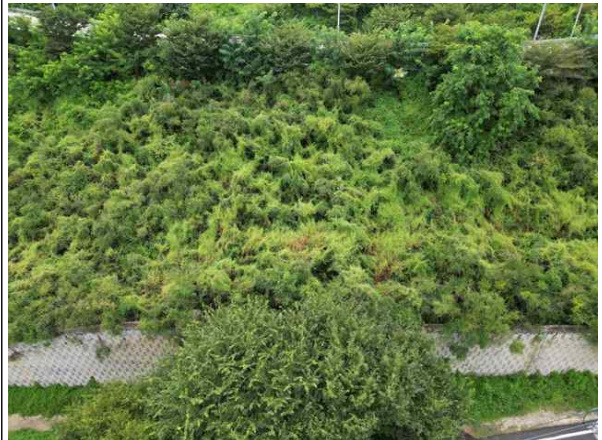
상부 성토부 전경
