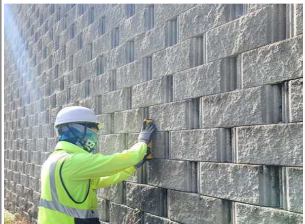
경사계를 이용한 경사도 측정
