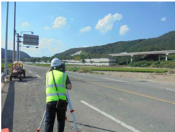
광파기를 이용한 측량 작업
