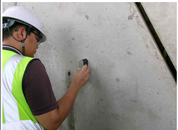
경사계를 이용한 경사도 측정
