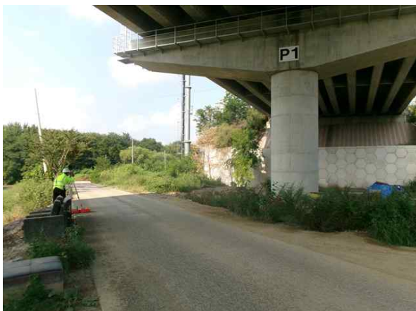
광파기를 이용한 측량 작업
