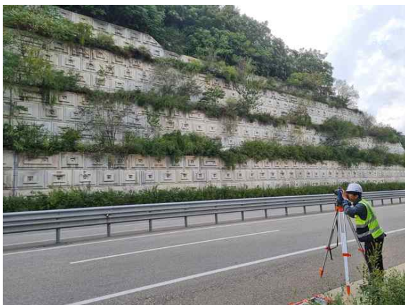
광파기를 이용한 측량 작업
