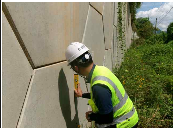
경사계를 이용한 경사도 측정
