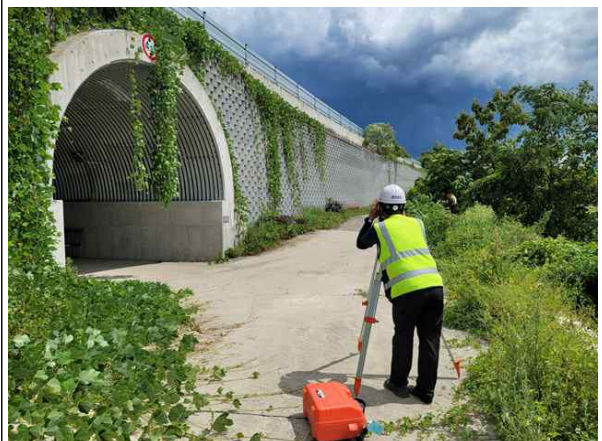
광파기를 이용한 경사도 측정
