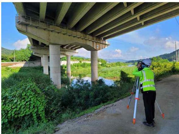
광파기를 이용한 측량 작업
