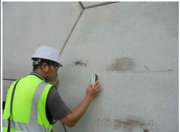
경사계를 이용한 경사도 측정
