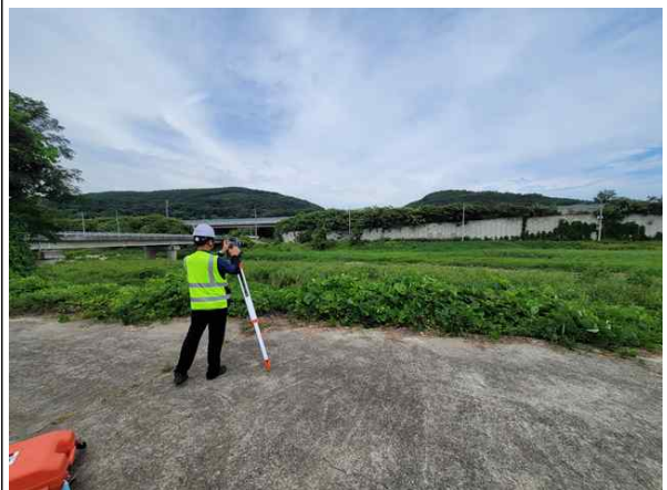
광파기를 이용한 경사도 측정
