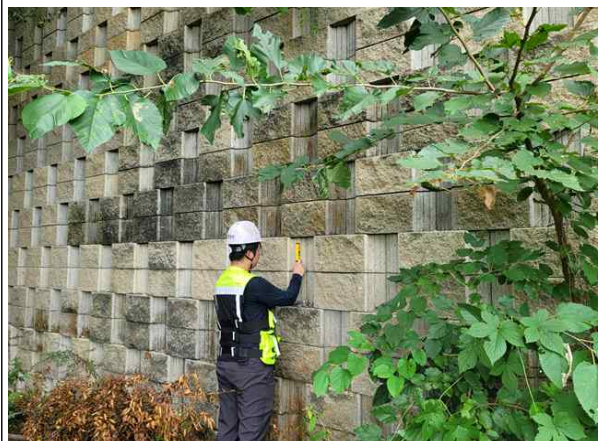
경사계를 이용한 경사도 측정
