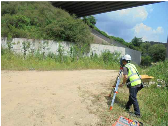
광파기를 이용한 측량 작업
