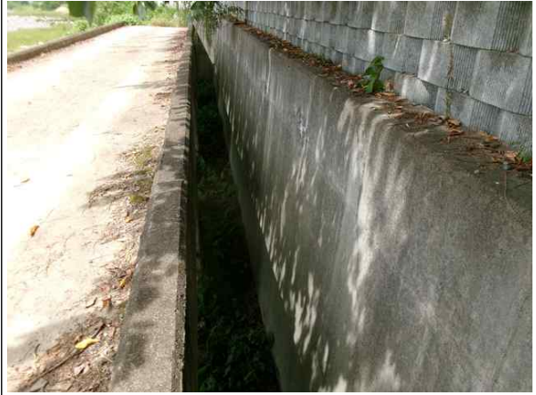
하부 배수로 전경
