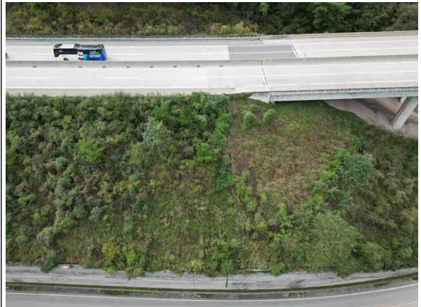
상부 성토부 전경
