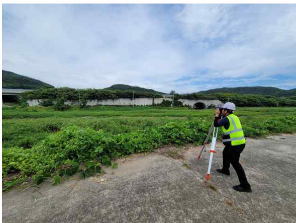
광파기를 이용한 측량 작업
