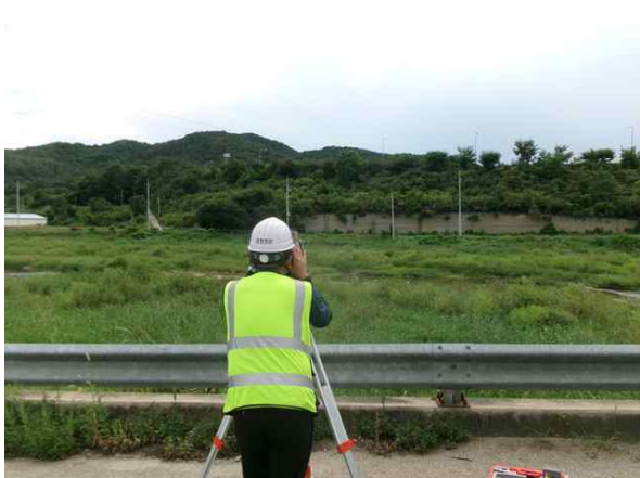
광파기를 이용한 측량 작업
