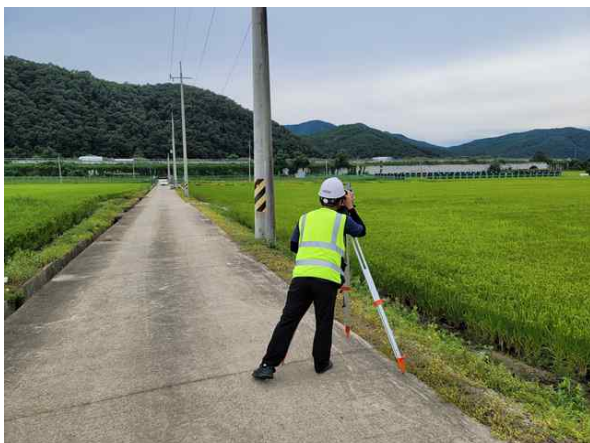
광파기를 이용한 측량 작업
