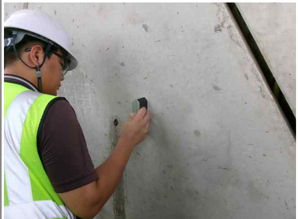
경사계를 이용한 경사도 측정
