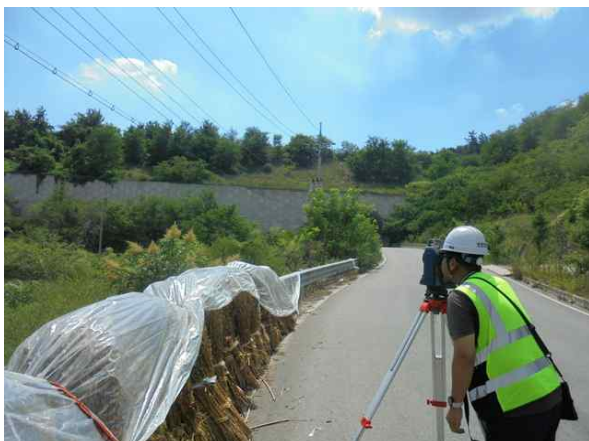
광파기를 이용한 측량 작업
