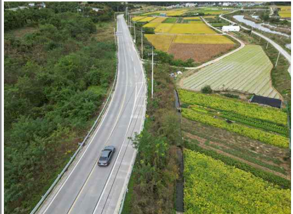
상부 성토부 전경
