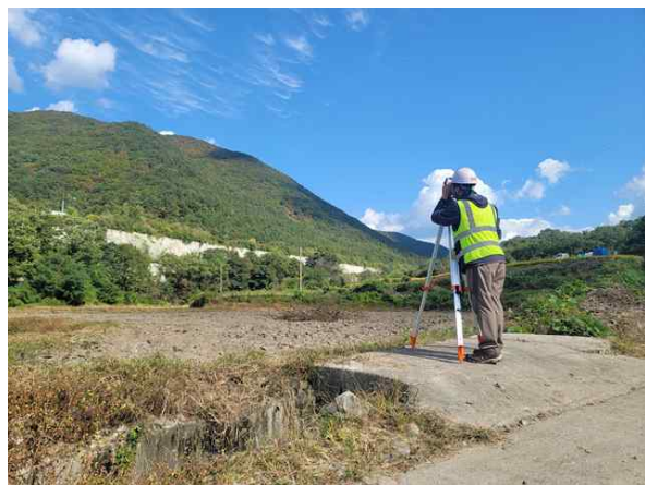
광파기를 이용한 측량 작업
