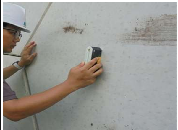
경사계를 이용한 경사도 측정
