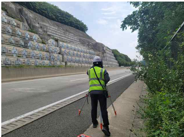
광파기를 이용한 측량 작업
