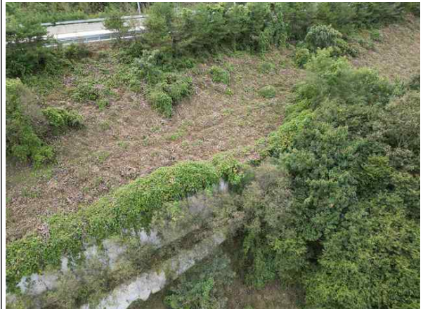
상부 성토부 전경
