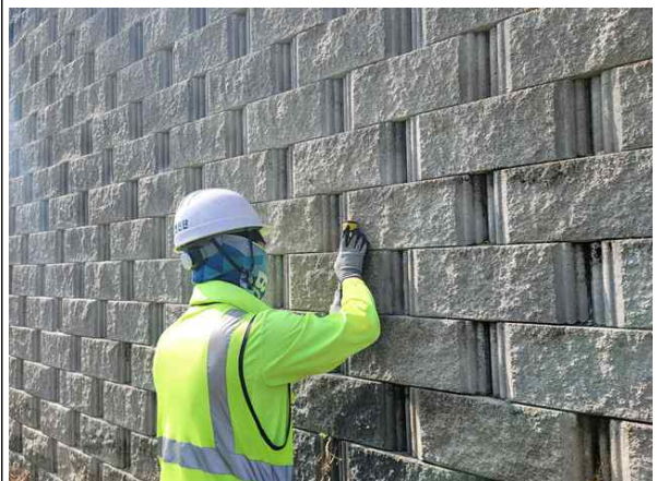
경사계를 이용한 경사도 측정
