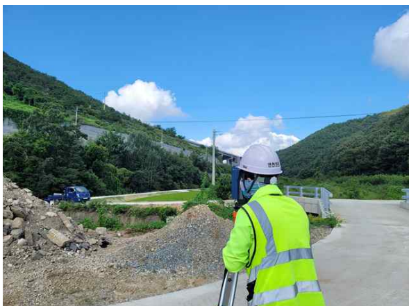
광파기를 이용한 측량 작업
