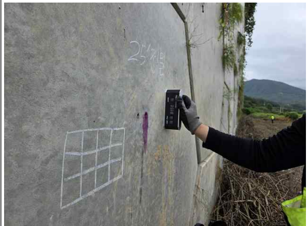
경사계를 이용한 경사도 측정
