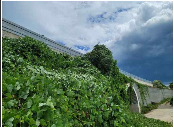
상부 성토부 전경
